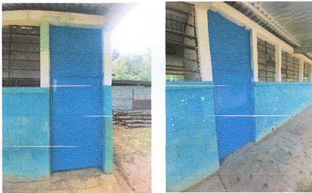
Foto 3: MEJORAMIENTO DE PUERTAS
